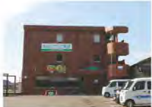
3号線沿い、レンガ調の建物の1階。和気藹々としたスタッフが笑顔で迎えてくれます。
