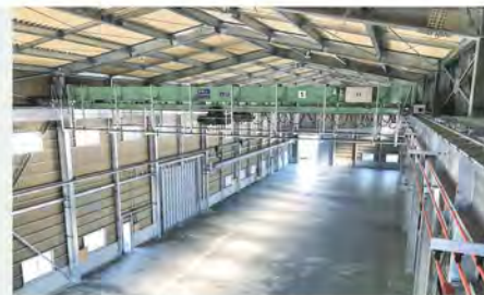
竣工間際の新築工場
